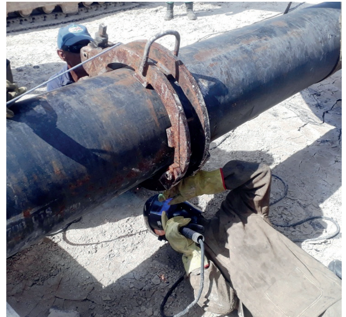
Bien acoplados deben quedar los tubos antes de comenzar a soldar.
