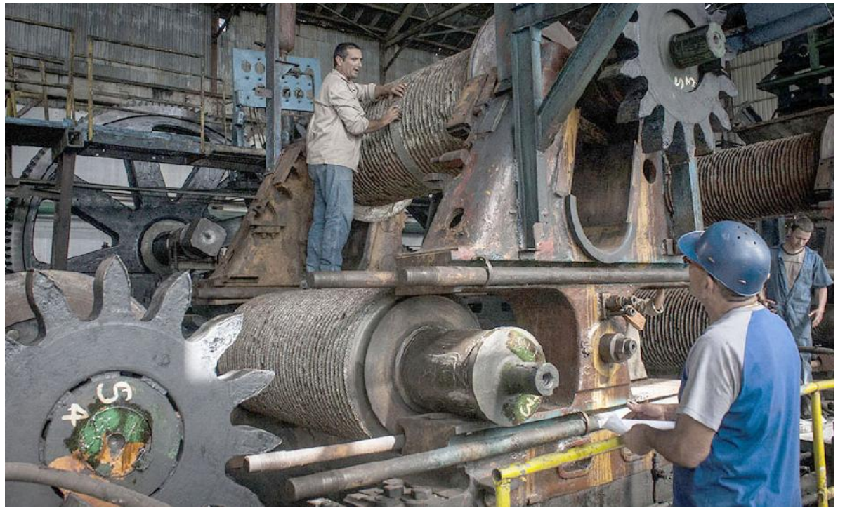
Hacer las reparaciones con calidad para lograr una próxima zafra con molidas estables es la premisa de los trabajadores del Melanio Hernández.
