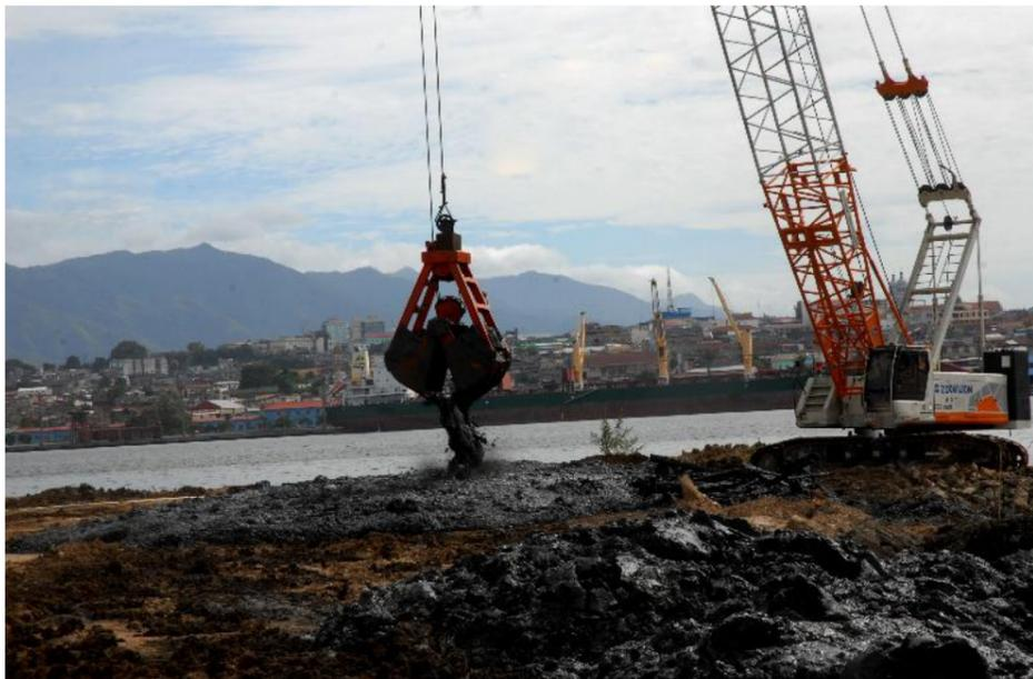
Luego de la evacuación del fango se hará una protección a base de un entramado de rocas a ambos lados del muelle.
