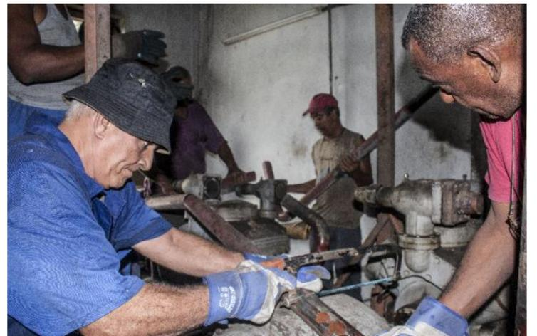
La brigada de mantenimiento a los equipos de aires acondicionados de los cines del Proyecto 23 del Icaic acomete por primera vez el desmontaje total de uno de los antiguos sistemas de climatización que con múltiples innovaciones ellos han conservado en funcionamiento, para dar paso a la próxima instalación de una nueva tecnología.
