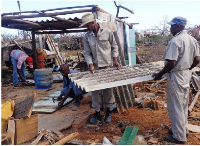
Brigada de constructores en plena faena. | foto: Rodny Alcolea
