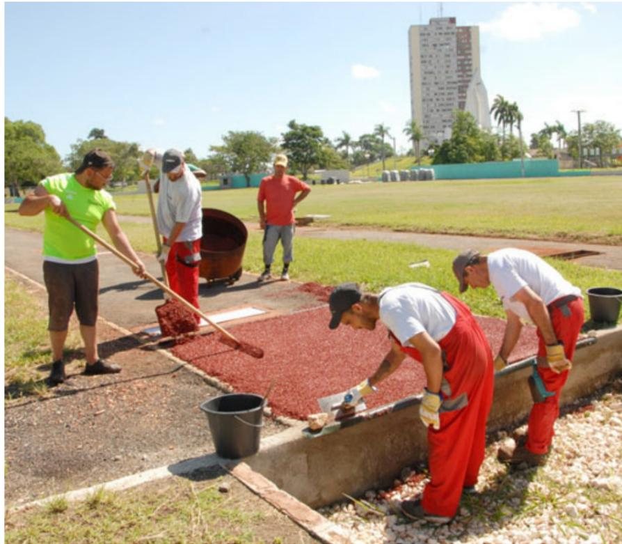
Técnicos alemanes instalaron la capa sintética de Polytan en una pista para salto de longitud. | foto: Otilio Rivero Delgado
