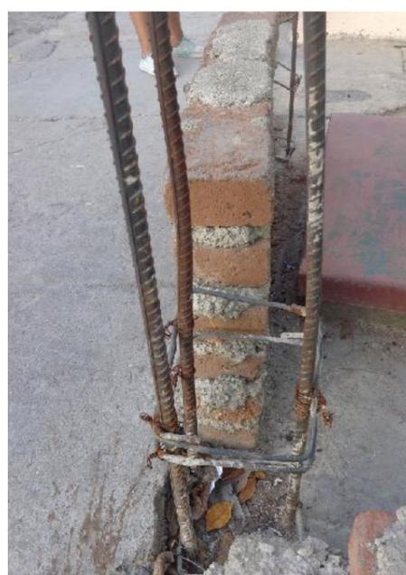
Fundir vigas y columnas utilizando solo tres barras de acero no es buena práctica en materia de construcciones sismorresistentes.
