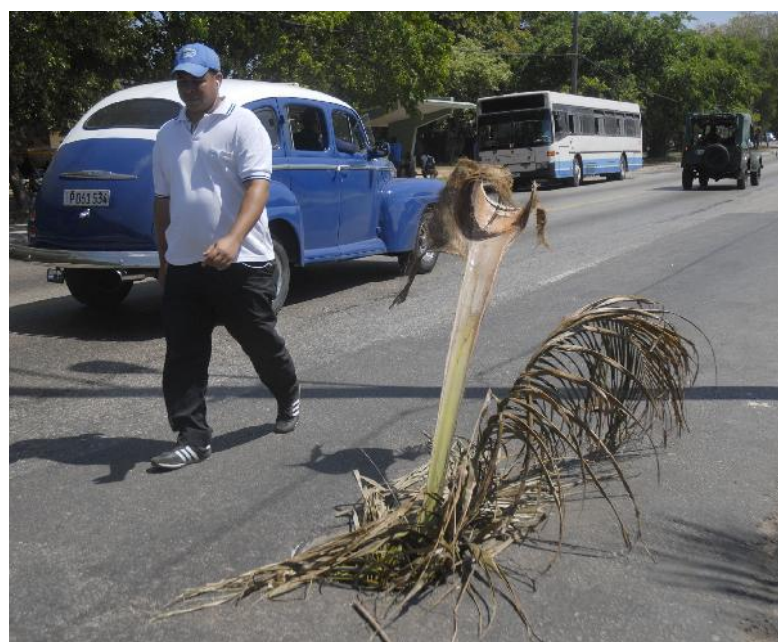
La falta de la tapa en una alcantarilla es peligroso para peatones y chóferes. Esta foto fue tomada hace varias semanas en la avenida 51 entre 220 y 218, en el capitalino municipio de La Lisa y así continúa, solo que la penca de la mata de coco está seca y reducida, al igual que la colocada muy cerca (220 y 51), donde alguien descompletó la batería de rejillas del drenaje pluvial. El hurto de ese tipo de tapas no es nuevo, y por épocas su desaparición prolifera en toda la ciudad. ¿Hasta cuándo actuarán impunemente quienes cometen tales hechos vandálicos? | texto y foto: Agustín Borrego Torres
