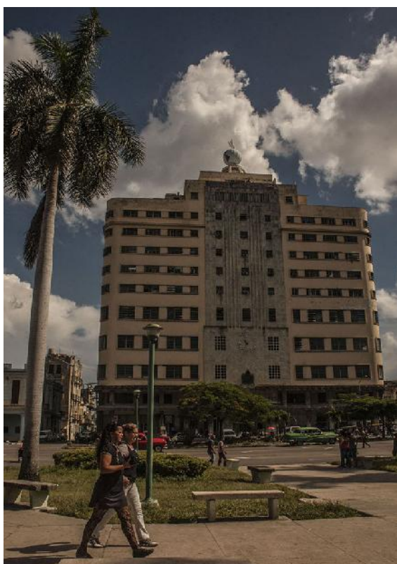
Entre los propósitos más inmediatos está poner a punto también el reloj de la fachada.
