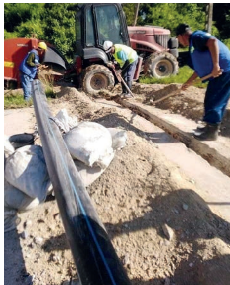
Cruce de carretera para conectar fuente de abasto de la comunidad de Demajagua. | foto: Delegación de Recursos Hidráulicos Granma
