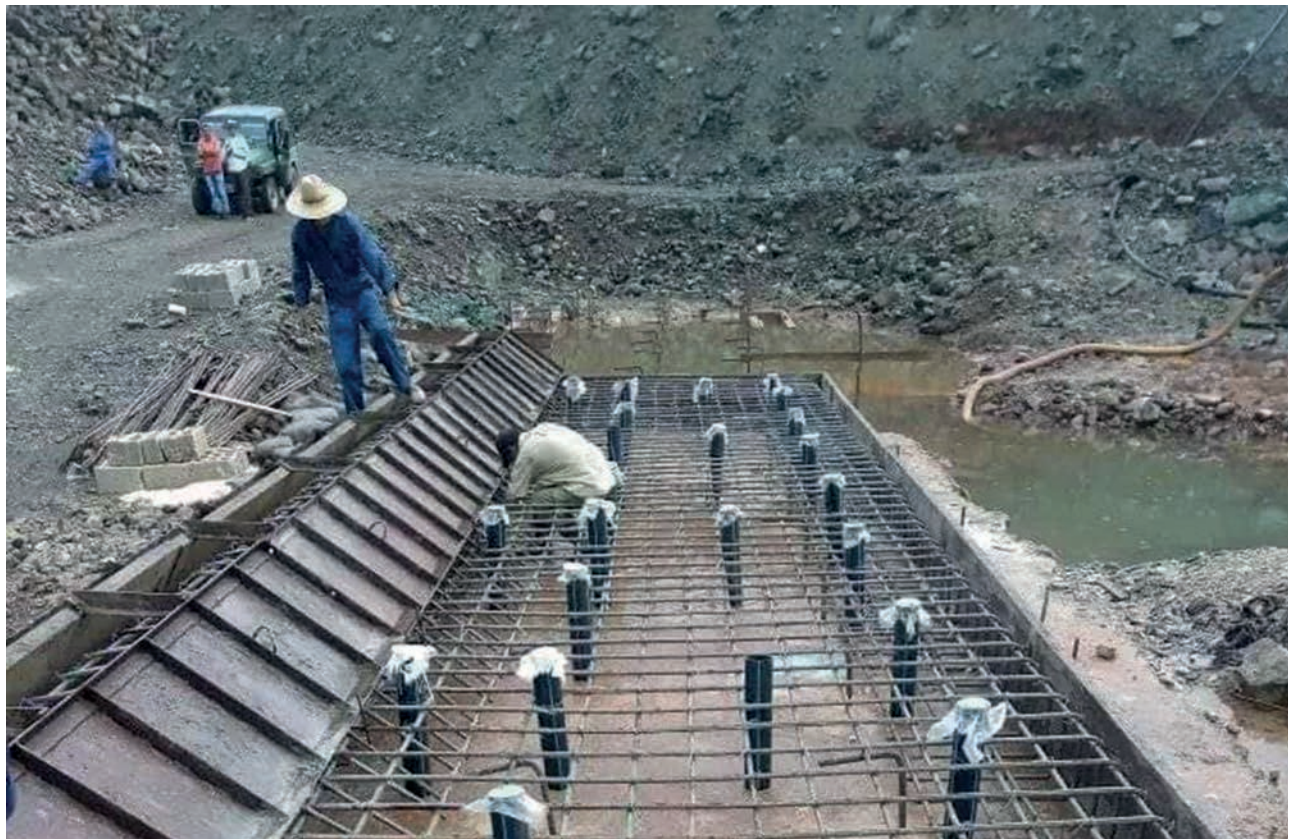
Entre las obras que enorgullecen a los constructores holguineros está la presa Levisa y otras asociadas al Trasvase Este-Oeste. | foto: Empresa de Servicios Ingenieros DIP Trasvases
