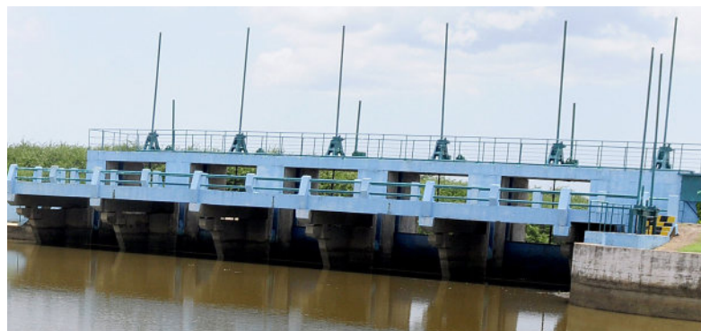
Por el río Hanábana se mueven 300 millones de metros cúbicos de agua anualmente. La Derivadora, que cuenta con dos canales magistrales para el cultivo del arroz en sus márgenes, posibilita elevar el nivel del agua.
