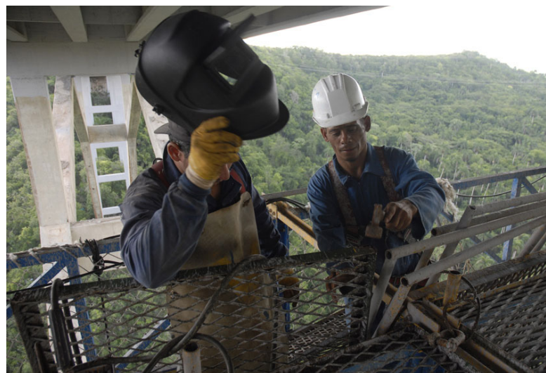
Desafiar el viento que muchas veces sopla fuerte sobre el puente y saberse a una altura considerable es la tarea que enfrenta una brigada de obreros de la Ecme. | fotos: Agustín Borrego Torres
