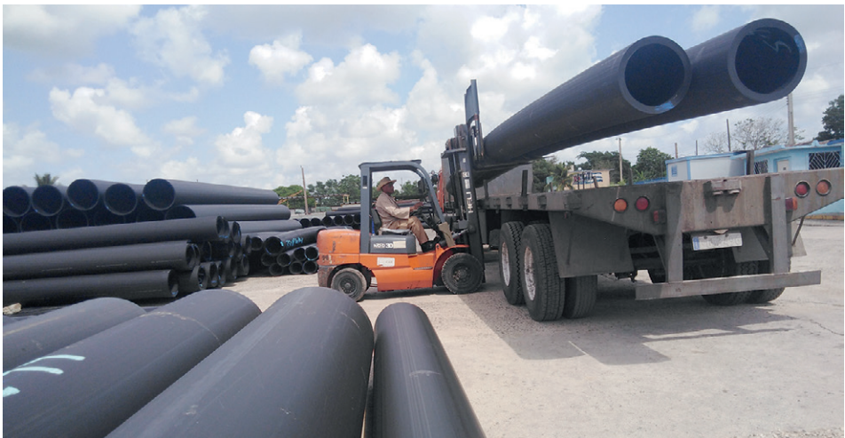
La calidad de las tuberías distingue la labor del colectivo. | foto: Del autor
