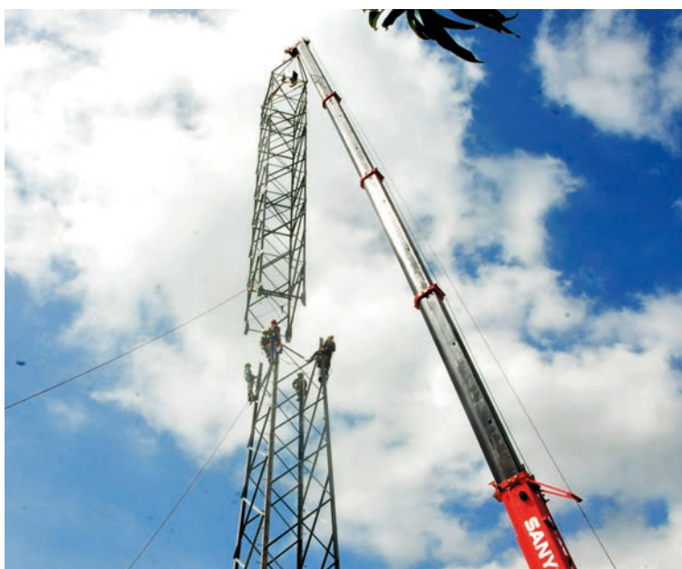
Izaje y colocación del último tramo.
