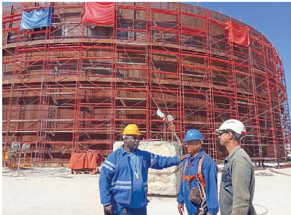
A base de talento, varilla a varilla, los operarios van consiguiendo esa soldadura robusta tan necesaria para la sostenibilidad del tanque 88. | foto: Noryis
