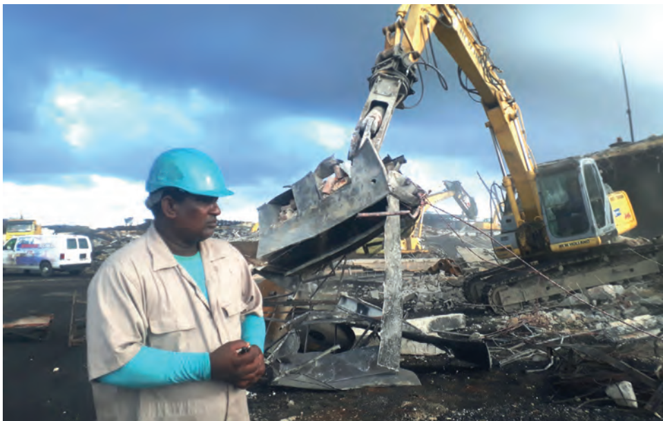
Con Irai Kindelán al frente, un rol fundamental en los cortes de tuberías y en las demoliciones cumple la brigada de materia prima de La Habana.
