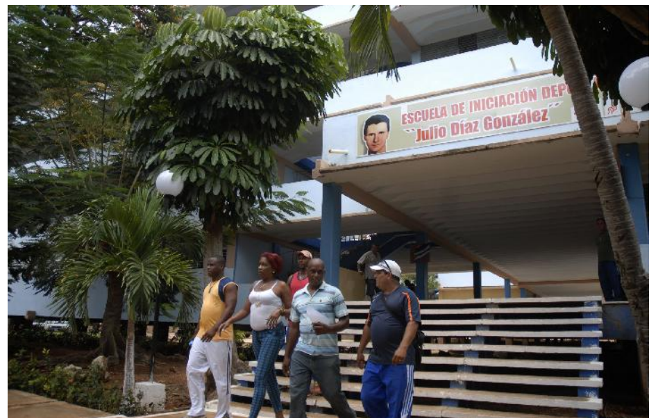
En la Eide Julio Díaz se realizan importantes acciones de reparación.
