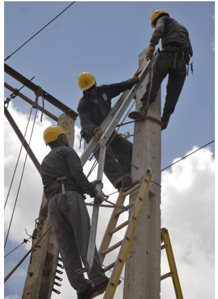
Se reparan redes eléctricas.
