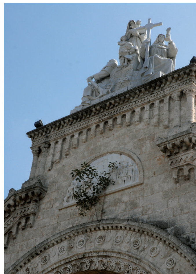
En la entrada principal del cementerio de Colón, patrimonio cultural de la nación, ha crecido lo que puede llegar a convertirse en árbol, además de causar deterioro y quizás hasta derrumbe del pórtico. Al parecer no hay quien se dé por enterado o decida la poda ahora que estamos a tiempo. | texto y foto: Agustín Borrego Torres
