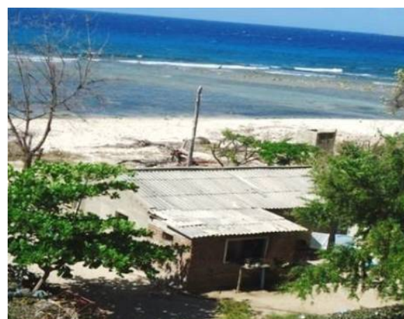
Violaciones constructivas en la playa.
