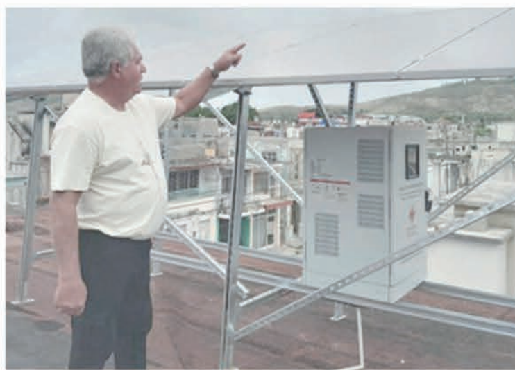
En lo alto del policlínico holguinero, cuatro módulos solares garantizan el funcionamiento óptimo del servicio de cuerpo de guardia | foto: De la autora
