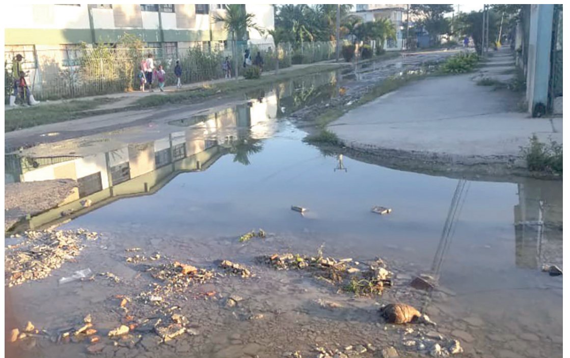
Frente a la escuela primaria Osvaldo Sánchez, ubicada en el reparto Martí, en el capitalino municipio del Cerro, existe un río permanente de aguas albañales y no se acaba de dar solución al problema, provocado por una mala conexión de la alcantarilla del barrio Cepero Bonilla. Esta desembocaba al río Mordazo y fue desviada a las colapsadas alcantarillas del reparto. Aguas de La Habana ha intentado resolver la situación y ha gastado gran cantidad de recursos con ese fin. Sin embargo, no terminan de eliminar la afectación. En tanto, las calles del reparto Martí se mantienen inundadas por fétidas aguas. | Texto y foto: Agustín Borrego Torres
