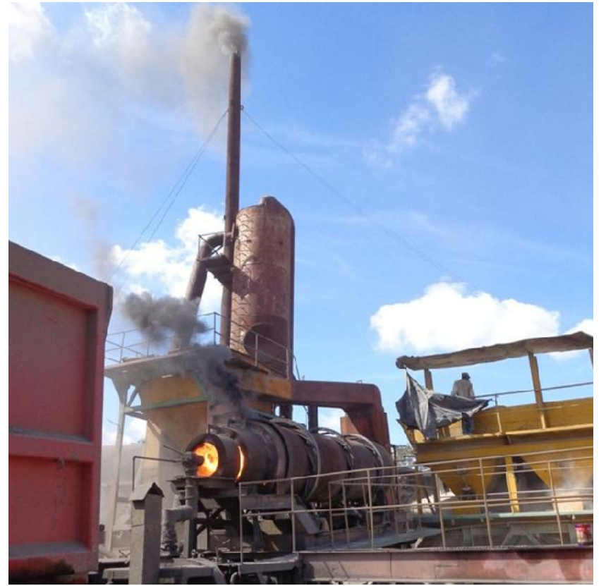
Esta imagen, que anuncia el funcionamiento de la Planta de Asfalto, ha sido muy intermitente en lo que va de año.
