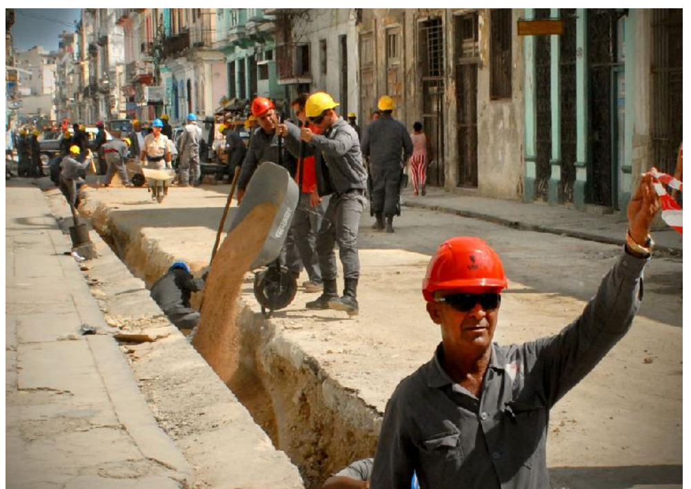
Trabajadores eléctricos de todo el país apoyan las labores de rehabilitación del soterrado de Centro Habana.
