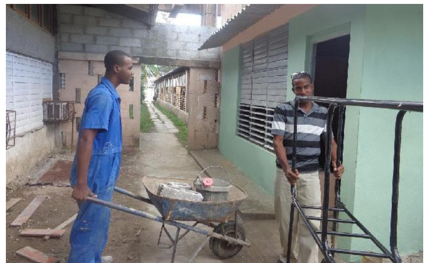
Las tareas constructivas en la Dirección Municipal de Planificación Física están concebidas a mediano y largo plazos. | foto: De la autora
